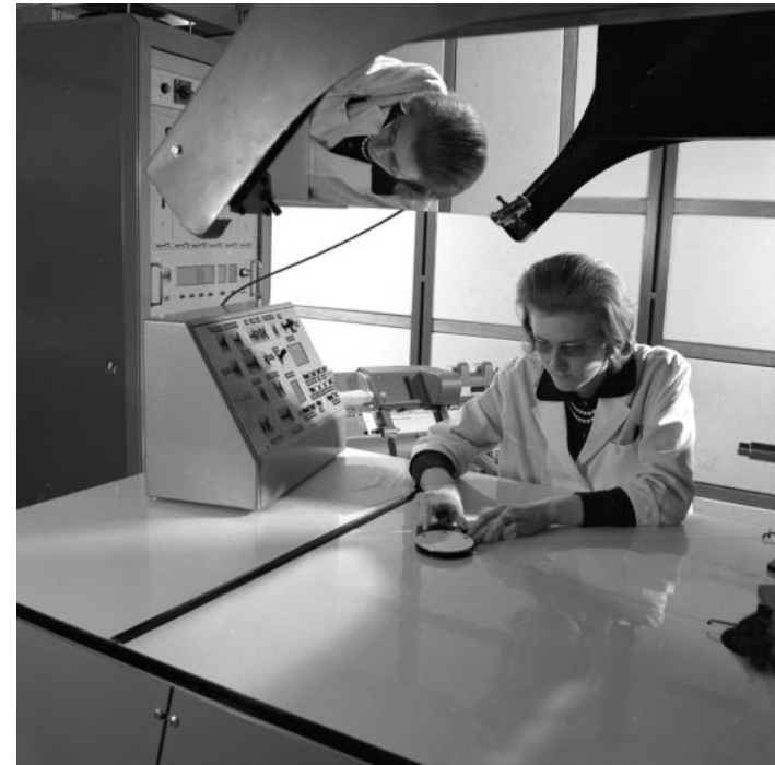
Tavolo per la scansione e misurazione (IEP) di fotografie generate in una camera a bolle, CERN, Ginevra, Svizzera, 08.03.1963 A scanning and measuring table (IEP) for bubble chamber photos, CERN, Geneva, Switzerland, 08.03.1963
