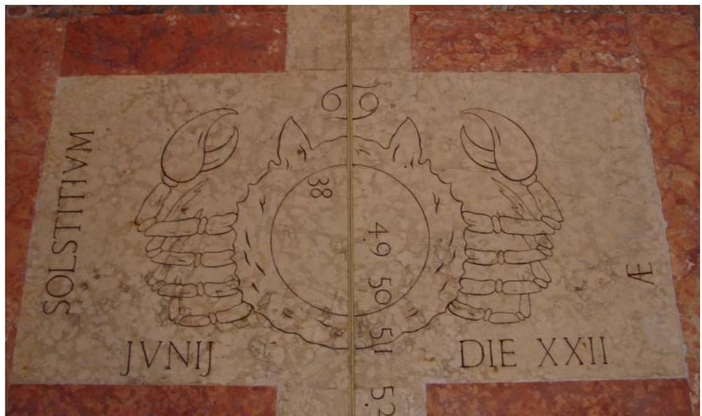
Nel nostro caso la parte solida dell'agglomerato, più chiara e resistente allo scalpello, si alterna a parti in cui il componente povero ed incongruo, per essere costituito da solfati ed argille debolmente compattate, minerali ferrosi e pomici sabbiose, si sgretola a vista, scalzato dai tacchi e dallo strofinamento dei piedi aiutato dall'umidità emergente e dai materiali chimici usati per la pulizia.
