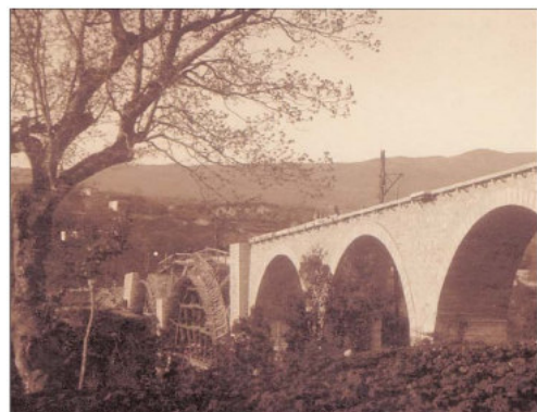
Procedono alacremente i lavori di costruzione del ponte sul Battiniero
