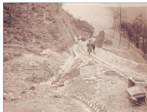
Lavori di sbancamento per il passaggio della ferrovia. Dirigenti in visita
