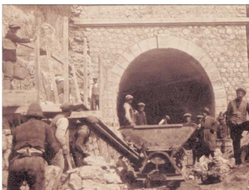
Operai in pieno fermento all'imbocco di una galleria
