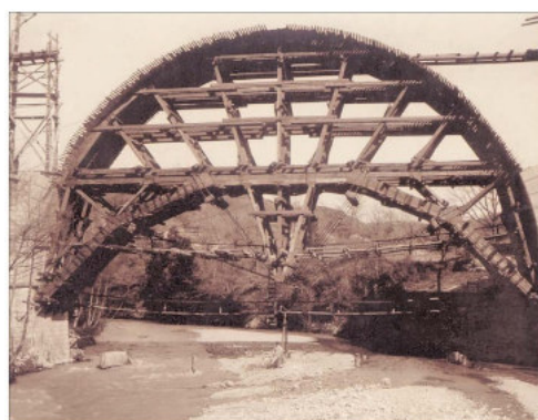
Altra vista dell'impalcatura, si noti il dedalo dei legni incrociati
