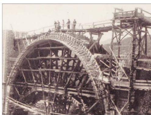
L'imponente struttura in legno per la costruzione dell'arcata centrale del ponte Battiniero
