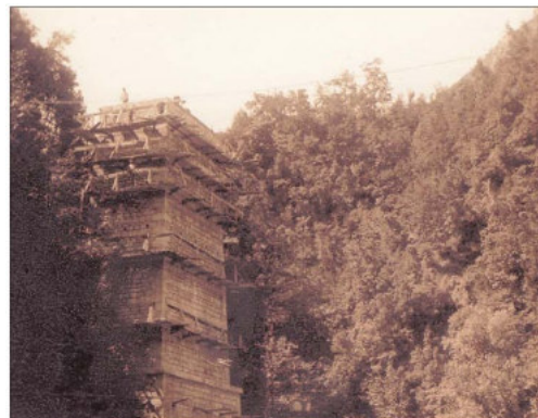
Strutture di armatura per la costruzione di una pila del ponte Battiniero
