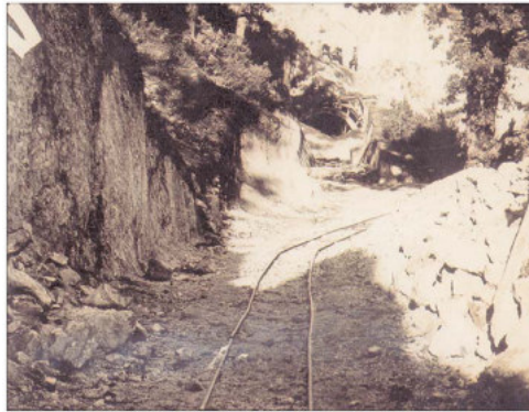
Tratto di linea in costruzione con binario provvisorio per lo spostamento materiali
