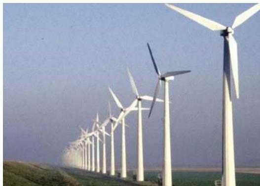
Diesel. Il tipo di aerogeneratore oggi più diffuso è quello di media taglia (500 - 900 kW), in grado di soddisfare il fabbisogno di 500 famiglie. L'altezza della torre è di circa 50 metri, con 1, 2 o 3 pale di 20 - 25 m ed un diametro variabile da 40 a 50 metri. La tendenza degli ultimi anni dimostra come la taglia media delle macchine installate sia in continua crescita e si stiano affermando sempre più sistemi di grande taglia.
